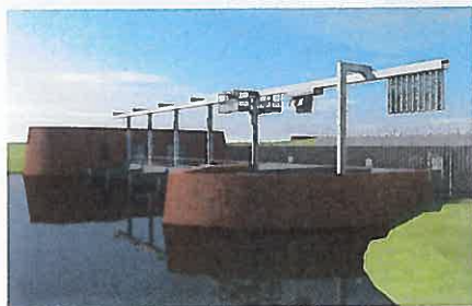
Het gemaal heeft een uitmaalcapaciteit van 2.000 m 3 per minuut en een inlaatcapaciteit van 500 m 3 per minuut.
